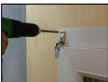
Fixer la sortie de caisson
