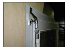
Manoeuvre de secours Tige manivelle décrochable.
