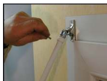
Fixer la tige manivelle à la sortie de caisson
