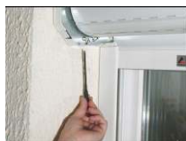
Retirer la sous-face, régler les fins de course et remettre la sous-face.
