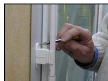
Positionner et fixer le bloqueur.
