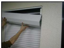
Dévisser et retirer la sous-face.
