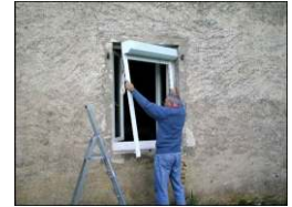
Retirer le volet Perçer et cheviller.
