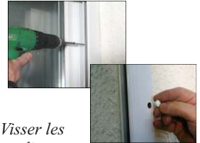
Retirer le volet Perçer et cheviller.
