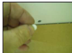
Visser la sous-face & clipper l'obturateur.
