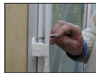
Positionner et fixer le bloqueur.
