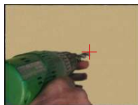
Reporter la position du cardan et percer à \text{Ø}16 .
