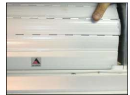
Engager le tablier dans les coulisses.
