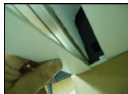
Clipper le profil de recouvrement.
