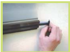
6. Emboîter les embouts de lame finale
