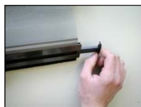
2. Emboîter les embouts de lame finale
