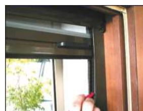
10. Emboîter les coulisses dans la queue de console. Pointer, percer et fixer les coulisses.
