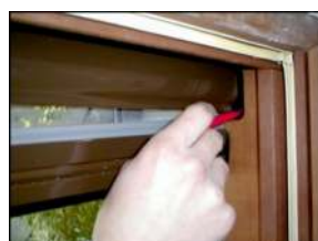
9. Monter les supports sur les consoles, et fixer le coffre (si montage avec support console*)
