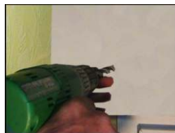
Reporter la position de sortie de sangle et percer à Ø 22.
