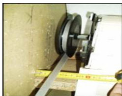
Repérer la position de la sortie de sangle.
