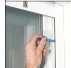
Pointer les trous de fixation des coulisses.
