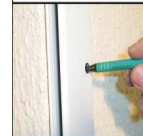
Pointer les trous de fixation des coulisses.
