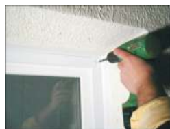
Pointer et percer la sortie à Ø10.
