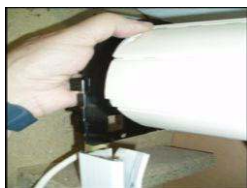
Emboîter le bloc dans les coulisses.
