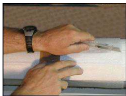
Retirer le film qui enveloppe le volet.
