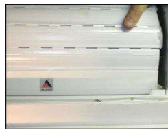
Glisser la lame finale dans les coulisses.
