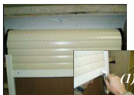
Descendre le tablier et fixer les butées (1)
