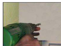
Reporter la position du cardan et percer à Ø16.
