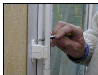
Positionner et fixer le bloqueur.
