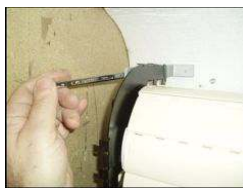
Positionner les jambes de force et bloquer avec une clé de 8.
