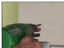
Reporter la position de sortie de sangle et percer à Ø 22.
