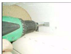
Fixer les jambes de force au linteau.
